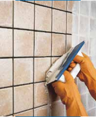
Spárování jedenkrát pálených obkladů gumovou stěrkou
