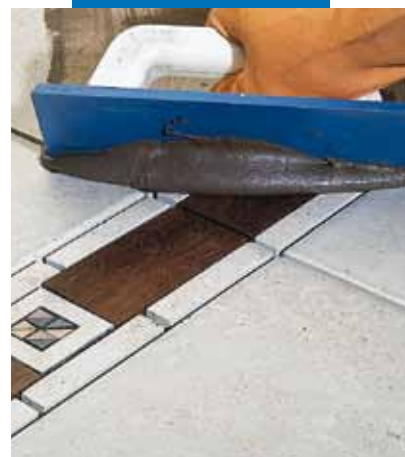
Spárování keramické dlažby s vloženými dřevěnými prvky stěrkou
