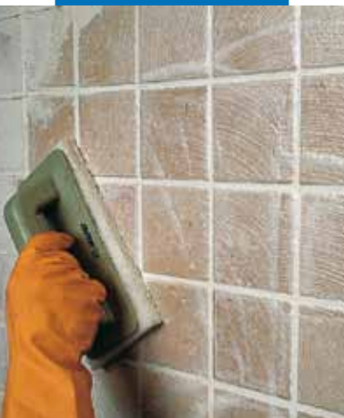
Konečná úprava jedenkrát pálených obkladů houbou Scotch-Brite®
