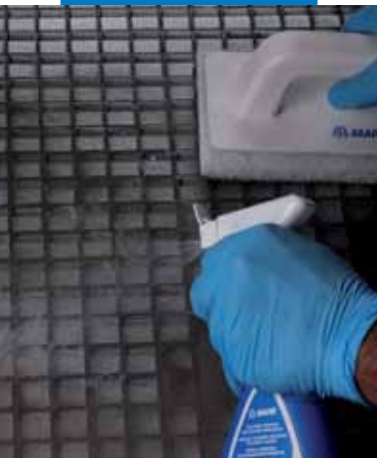
Nástřik výrobku Kerapoxy Cleaner na čišťený povrch
